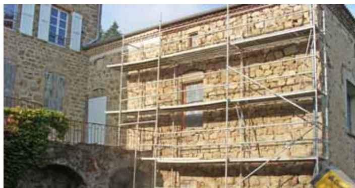
Travaux extérieurs magnanerie
